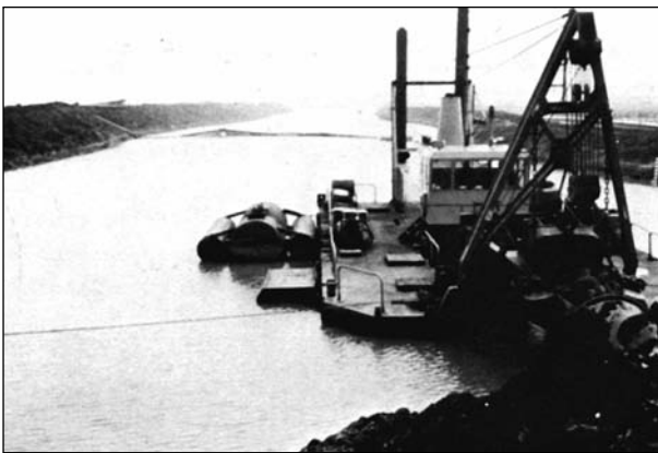
Bild 4.25: Cutter für den Nassbaggerbetrieb (QUAST, 1980)
