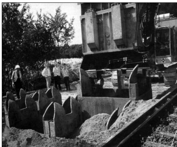
Bild 4.28: Ziehen bzw. Einvibrieren der Stahlkästen beim Rüttelkastenverfahren
