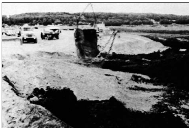
Bild 4.20: Vorkopfbetrieb bei der Andeckbauweise (QUAST, 1980)
