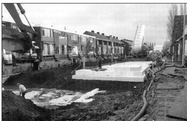
Bild 5.7: Einsatz von Blähton und EPS als Ersatzmaterialien zum Zwecke der Lastreduzierung
