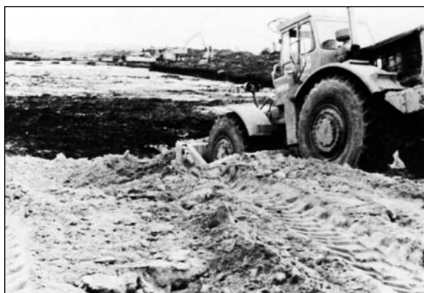
Bild 4.21: Schlammwalzenbildungen im Trockenbetrieb (QUAST, 1980)
