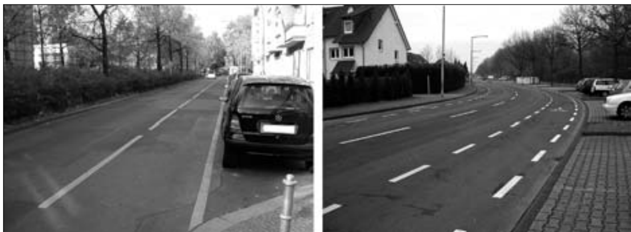
Bild 5.3: Schutzstreifen mit Abweichungen von der VwV-StVO, links: abweichende Markierung, rechts: überbreite Restfahrbahn
