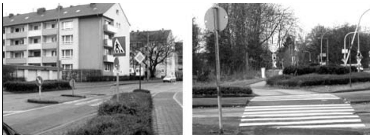
Bild 5.15: Nicht StVO-konforme Fußgängerüberwege, links: unvollständige Beschilderung und Mehrfachbeschilderung am gleichen Mast, rechts: Anordnung im Zuge eines kombinierten Geh- und Radweges als Verbindungsachse im Radverkehr
