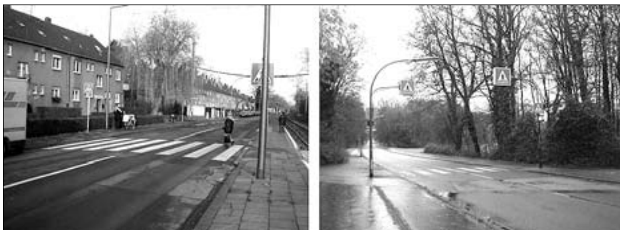
Bild 5.42: StVO-konformer Fußgängerüberweg mit mehreren Überschreiten-Unfällen (links), Fußgängerüberweg mit Unfällen mit querenden Radfahrern im Zuge einer Verbindungsachse im Radverkehr (rechts)
