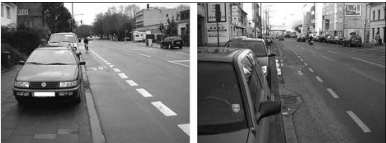
Bild 5.18: Schutzstreifen mit abweichender Markierung (links) und zu breiter Restfahrbahn (rechts)
