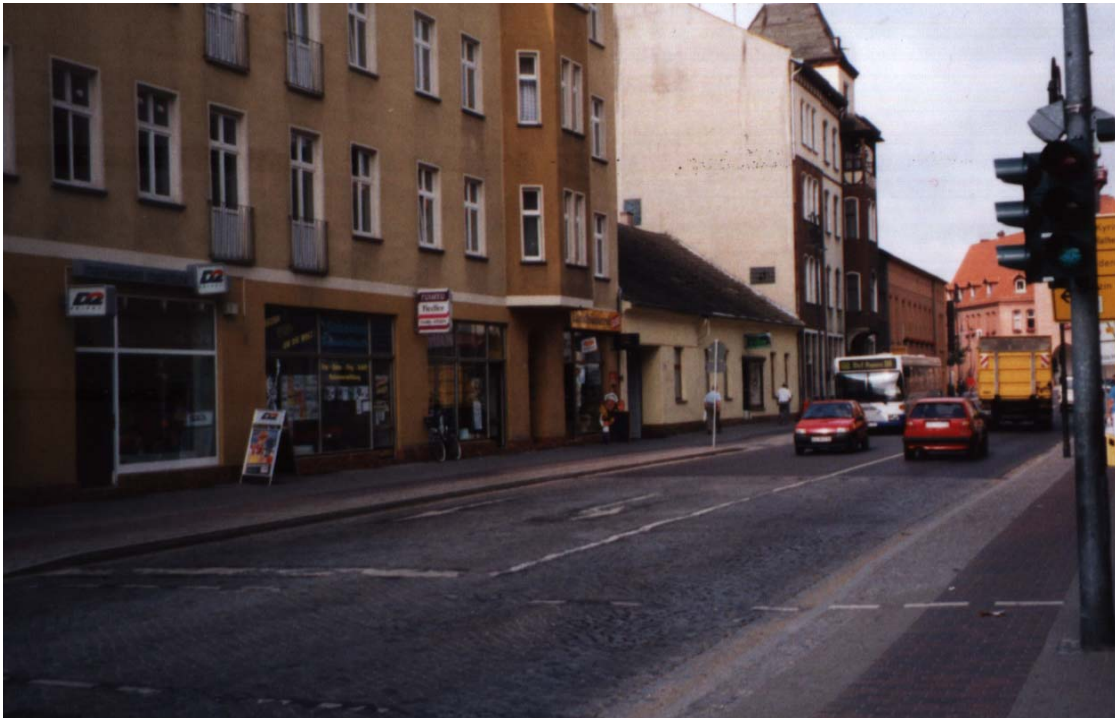
Abb. 4.6: Blick in die Berliner Straße in Richtung Süd-West im Juli 1997, also noch vor dem Fahrbahnbelagswechsel. Zu sehen ist im vorderen Teil der vielfach geflickte Kleinpflasterbelag. Die Messstelle befindet sich an dem hohen Gebäude links neben dem Bus. (Quelle: Lohmeyer, 2003b)
