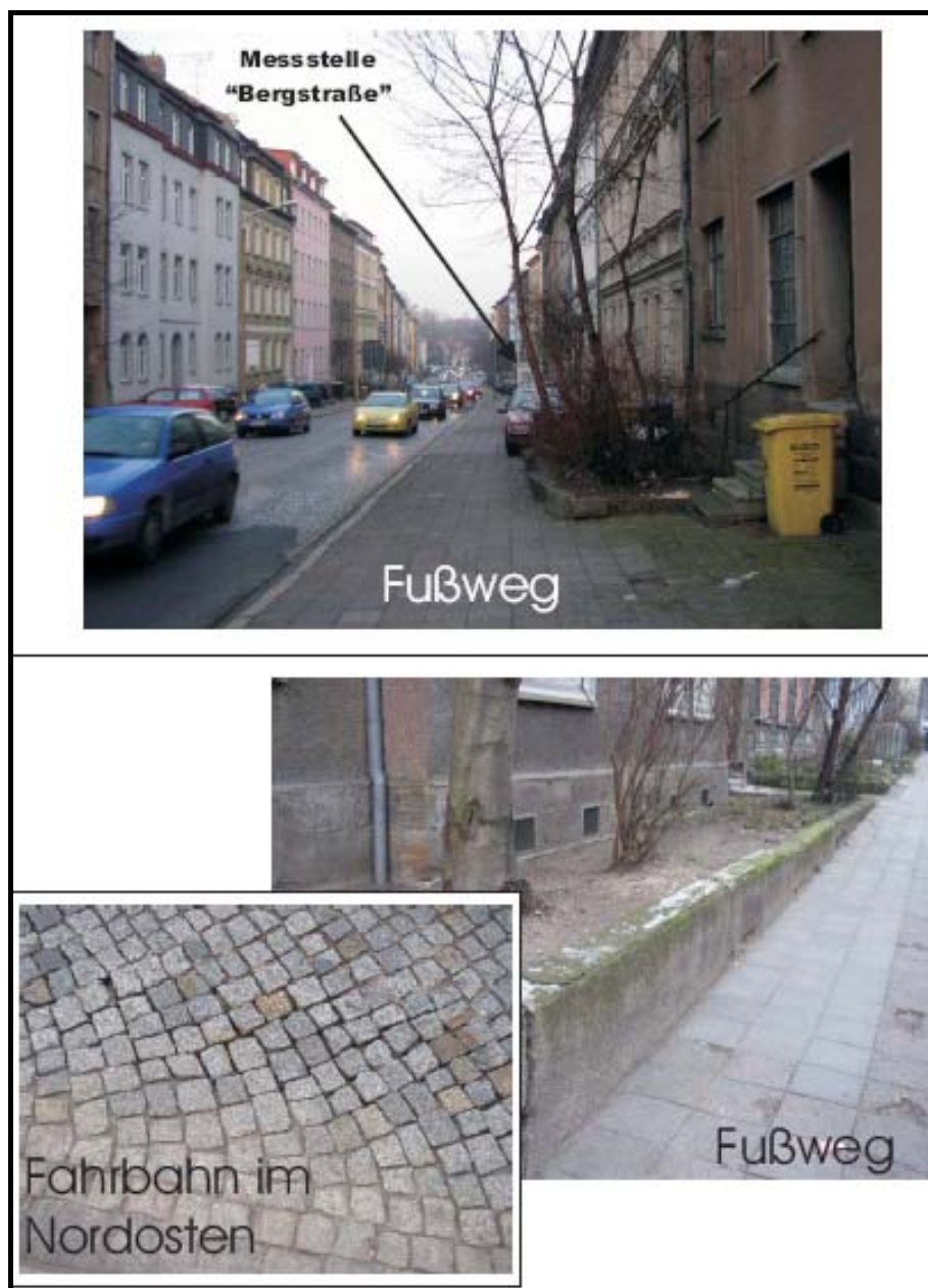
Abb. 4.8: Erfurt Bergstraße vor der Sanierung (oben: Blick von der Nordhäuser Straße in die Bergstraße; unten: Fahrbahnbelag und Beschaffenheit des Gehweges) (Quelle: Moldenhauer et al., 2004)
