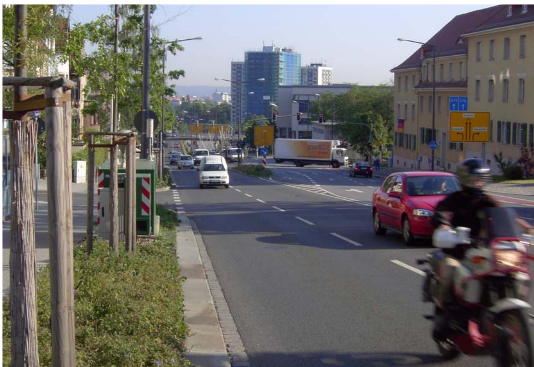
Abb. 4.4: Blick in die Bergstraße in Richtung Süd (oben) bzw. Nord (unten) nach dem Ausbau. Im oberen Bild Rechts ist der derzeit eingesetzte Messcontainer Dresden-Bergstraße zu erkennen.
