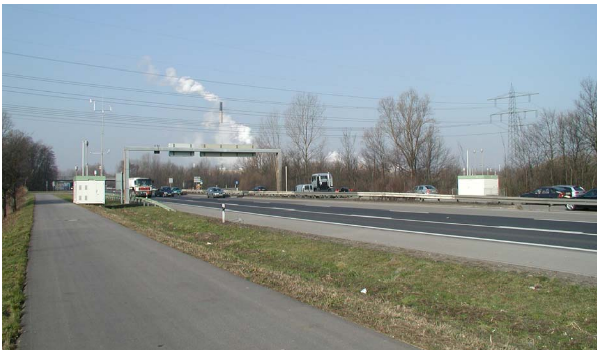
Abb. 4.2: Blick auf den Bereich der Messstellen an der B 10 bei Karlsruhe in Richtung Ost (oben) bzw. in Richtung West (unten)
