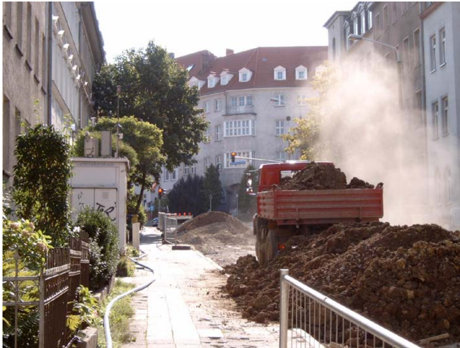
Abb. 7.4: Situation im Bereich der Messstelle (links) am 12.09.2006
