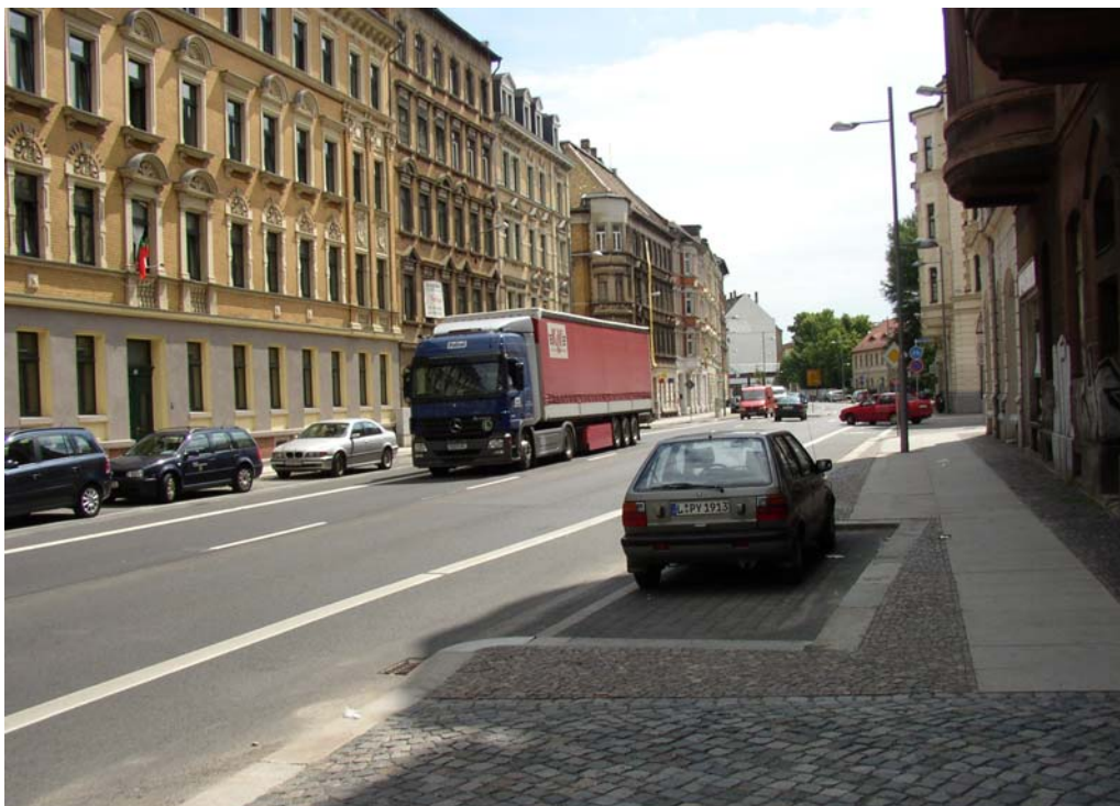
Abb. 4.3: Blick in die Lützner Straße stadteinwärts (unten) sowie stadtauswärts mit Messstelle (oben) für den Zustand nach der Sanierung
