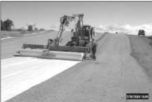
Bild 3: Einbau Geokunststoff
