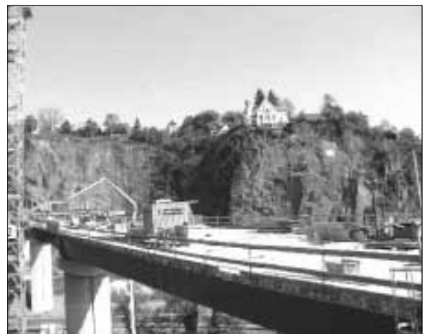
Bild 5: Weisseritztalbrücke mit denkmalgeschütztem Haus
