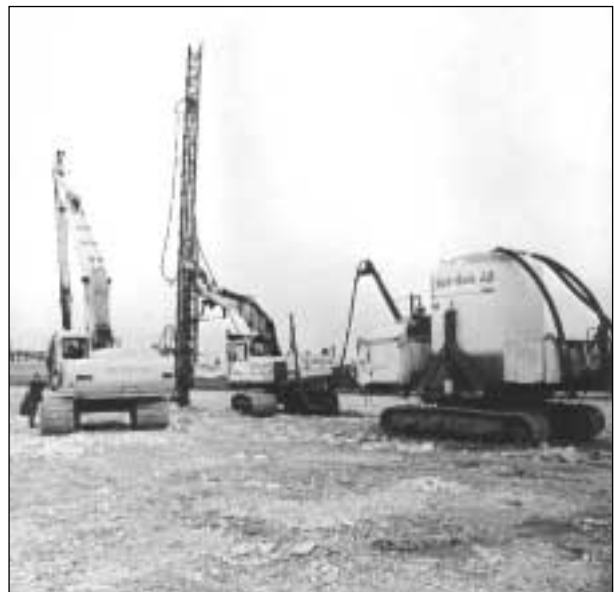
Bild 13: Herstellung von Zement-Boden-Säulen (England, Port of Hull, 2001, Bild: Fa. Keller)
