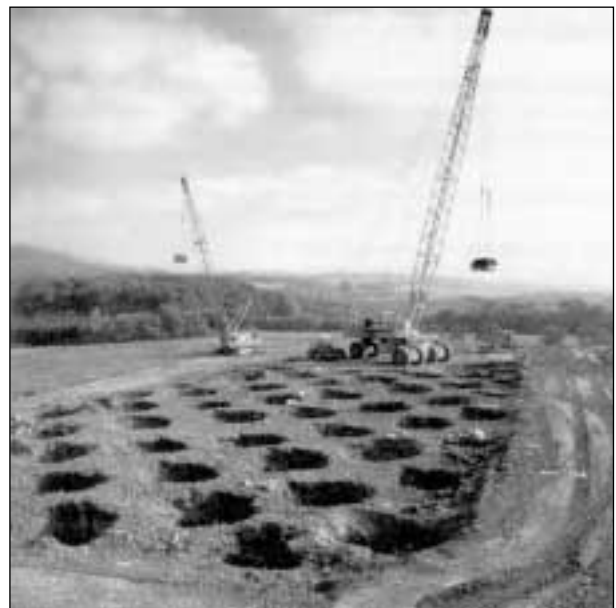
Bild 9: Dynamische Intensivverdichtung (Bild: KOLYMBAS)
