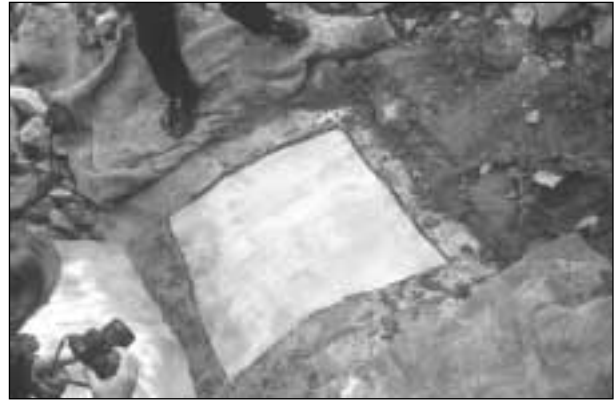
Bild 6: Freigelegte GTD zur Probenentnahme in der Ausweichstelle Eberswalde
