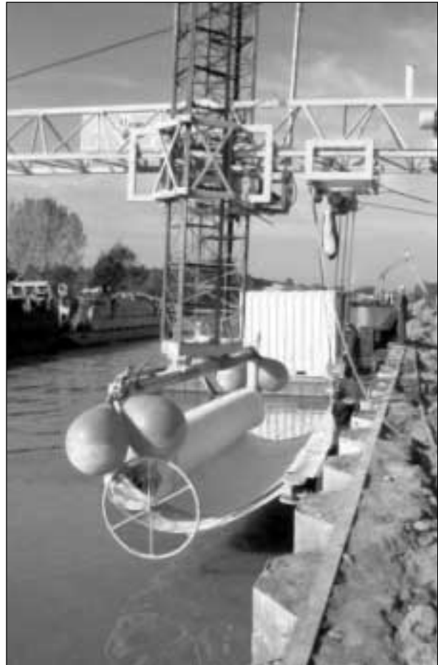
Bild 3: Verlegegerät mit versetzt aufgerollter Bentonit- und Sandmatte
