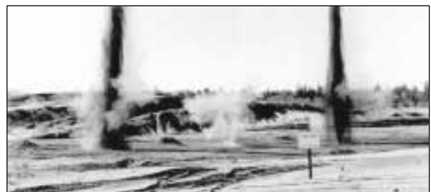
Bild 10: Sprengverdichtung (Bild: Fa. BUL Brandenburg)
