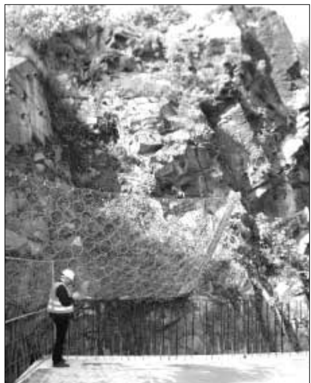
Bild 9: Übergang Weisseritztalbrücke-Tunnel Coschütz mit Sicherung Naturdenkmal
