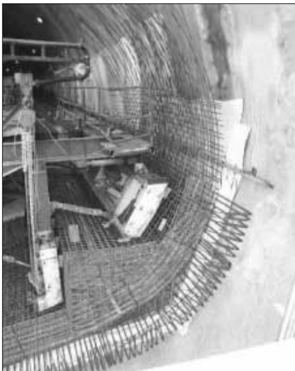
Bild 6: Detail Bewehrungsaufbau am Tunnel Dölzchen
