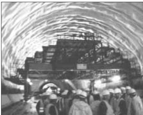
Bild 7: Tunnel Dölzchen mit eingebrachter Dichtfolie
