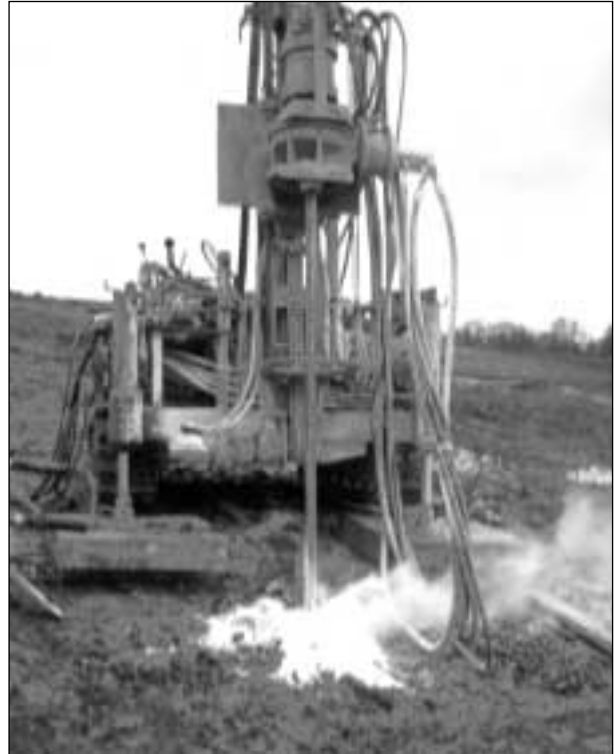
Bild 12: Herstellung von Kalk-Boden-Säulen mittels Vor- und Überbohren
