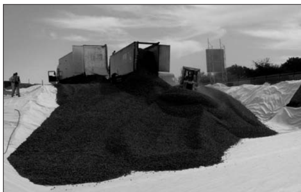
Bild 5: Anlieferung und Verteilung von Glasschaumgranulat
