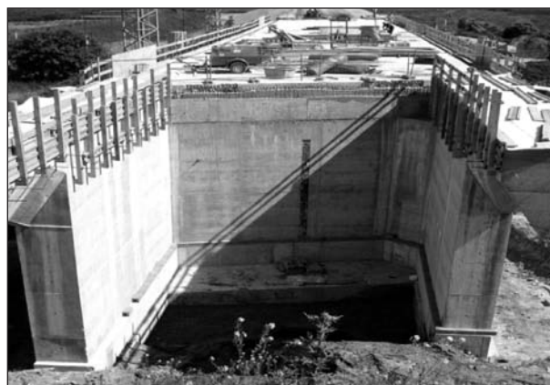
Bild 3: Unverfülltes Widerlager vor Einbau
