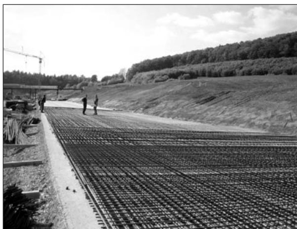
Bild 2: Bewehrung der Stahlbetonplatte
