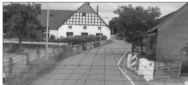
Bild 22: Lage der Engstellen im Ort – Ortseingang
