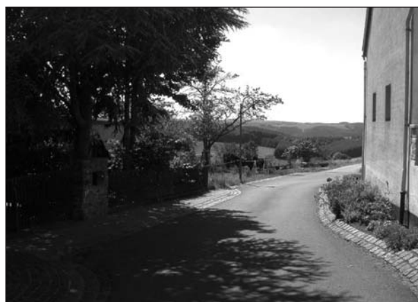
Bild 103: Bepflanzungen von Schrammborden zur Markierung des Schutzraumes und zur Vermeidung seiner Nutzung als Gehweg
