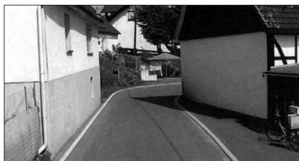
Bild 37: Straßenverlauf im Bereich der Engstelle – unübersichtliche Kurve
