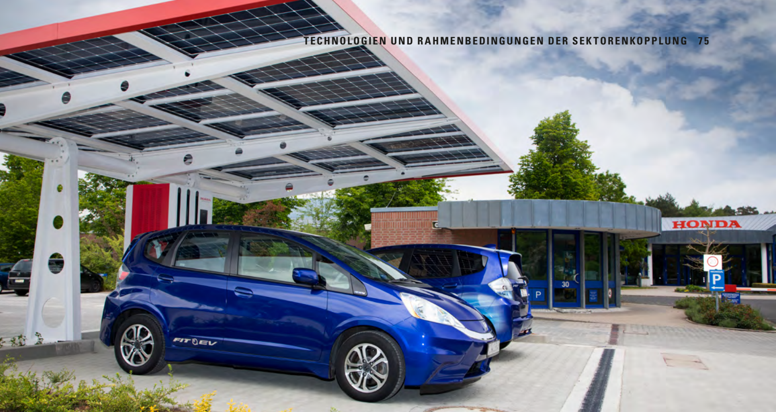
Abbildung 18: Solar Carport mit integrierter Ladestation (Foto: Honda)
