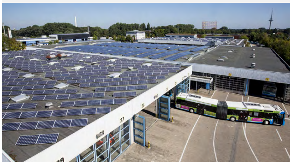
Abbildung 11: Busdepot mit PV-Dachanlage der Stadtwerke Münster (Foto: Stadtwerke Münster)
