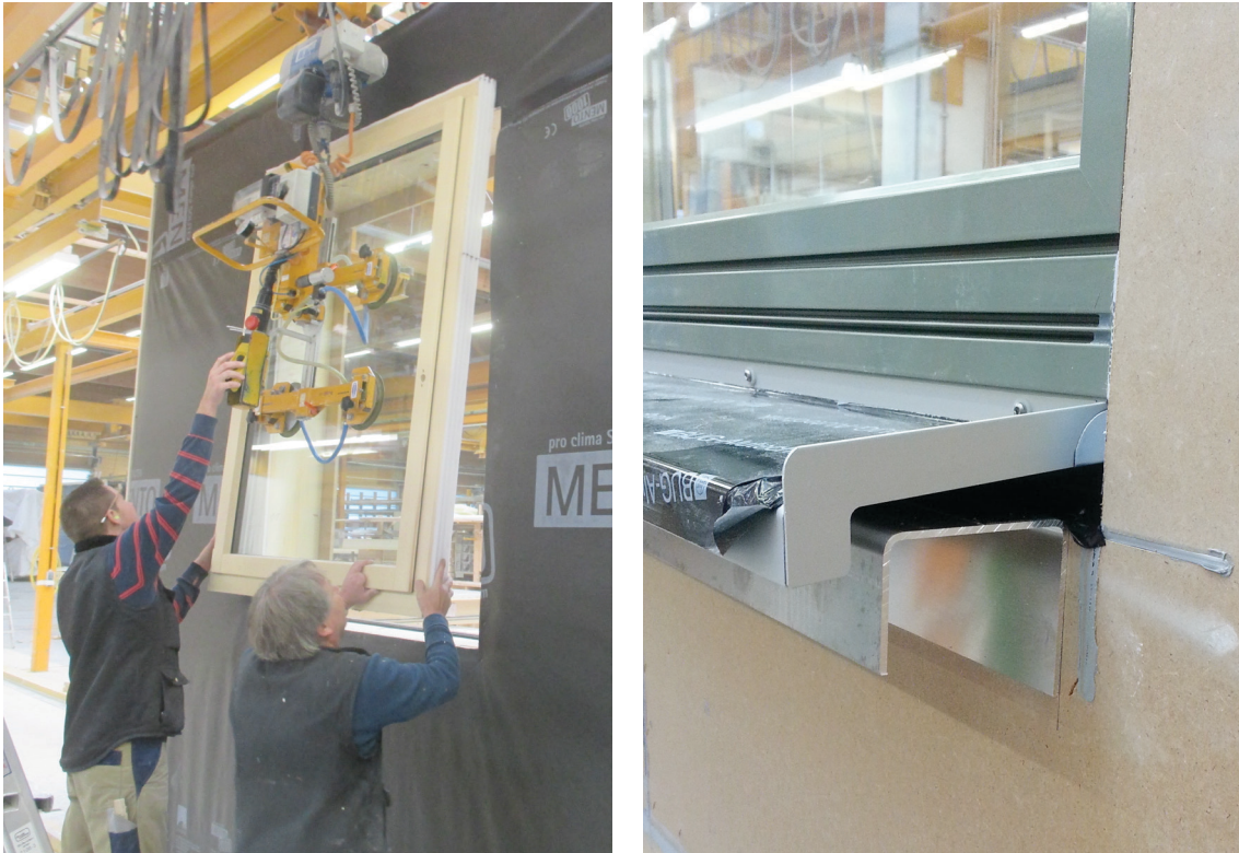
Abb. 43 Montage Fenster und Detail Brüstung mit Fensterbank und Glashalteprofil (Fotos: BAUFRTIZ)
