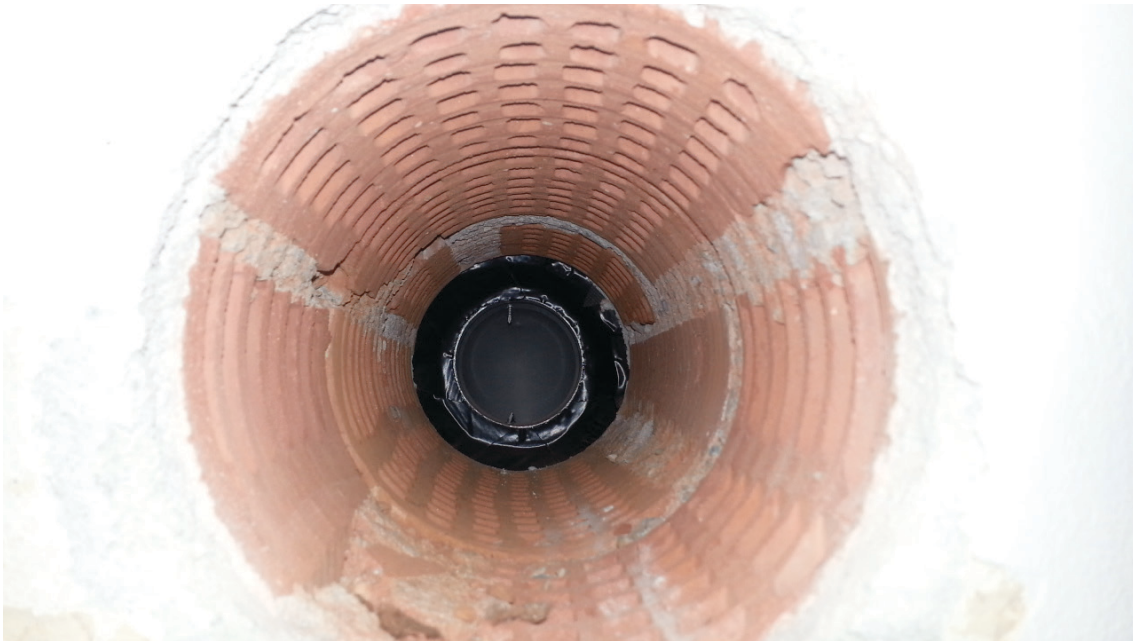
Abb. 49 Kernbohrung mit Lüftungsstutzen Fassadenelement (Foto: BAUFRITZ)
