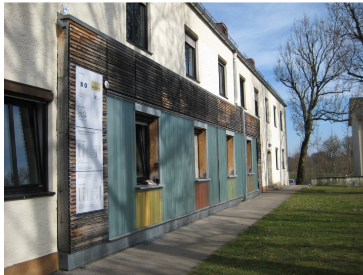
Abbildung 4: Sicht von Laserscannerstandpunkt 2 auf Fassade
