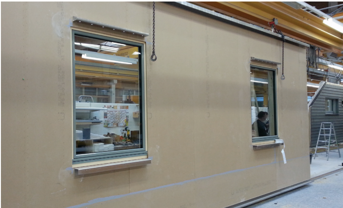
Abb. 44 Fertiges Wandelement (Foto: BAUFRTIZ)
