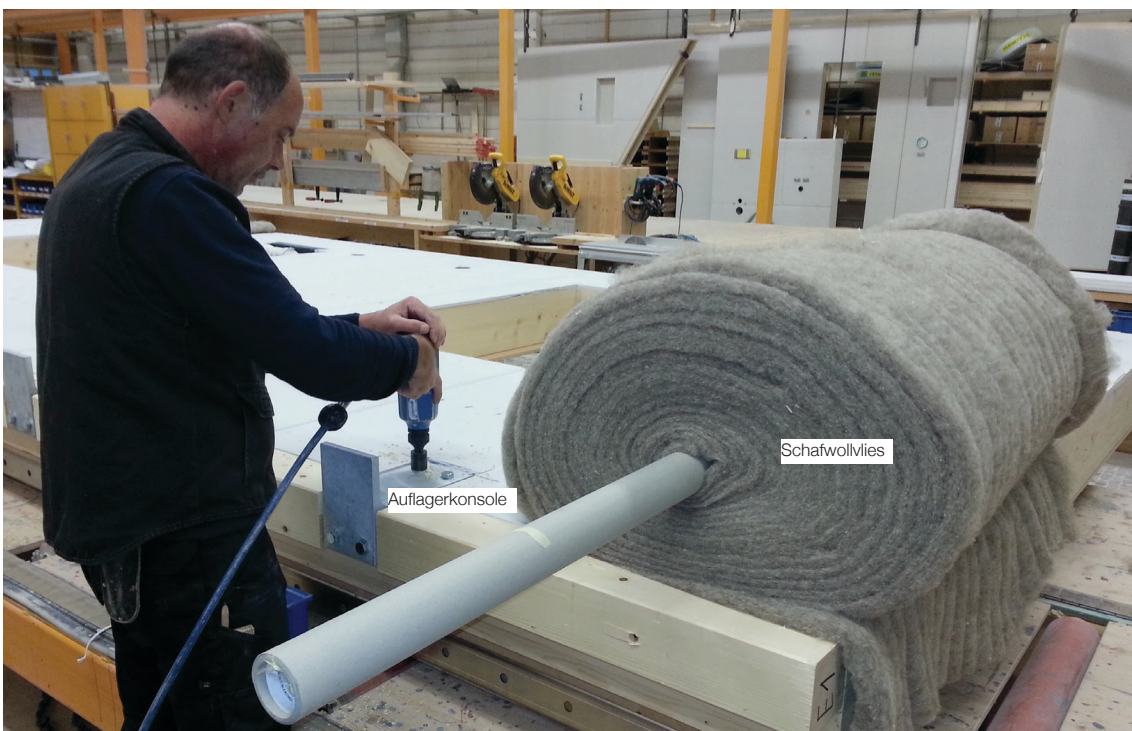
Abb. 42 Montage der Auflagerkonsolen und Aufbringen des Schafwollvlieses (Foto: BAUFRTIZ)
