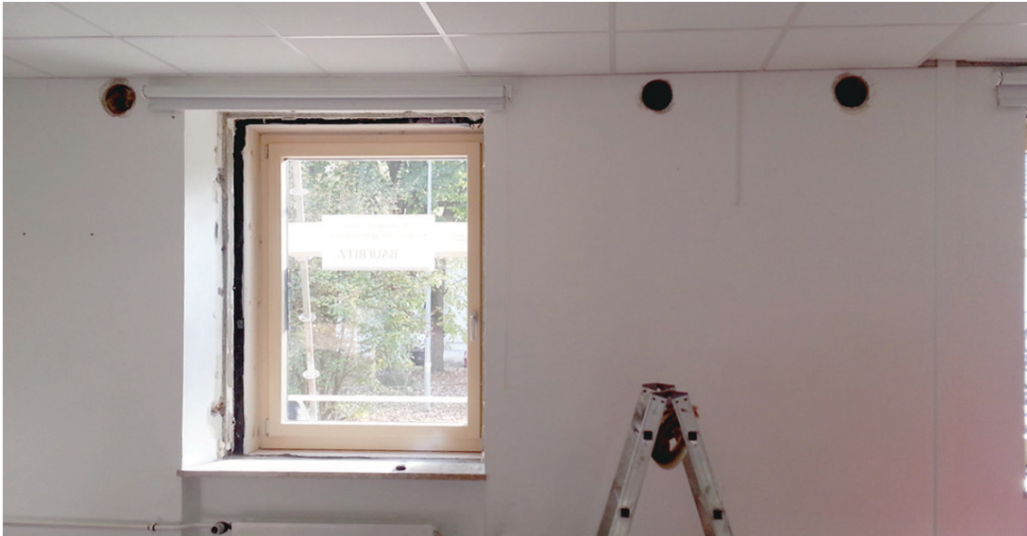
Abb. 47 Situation Zimmer während der Bauarbeiten (Foto: BAUFRTIZ)
