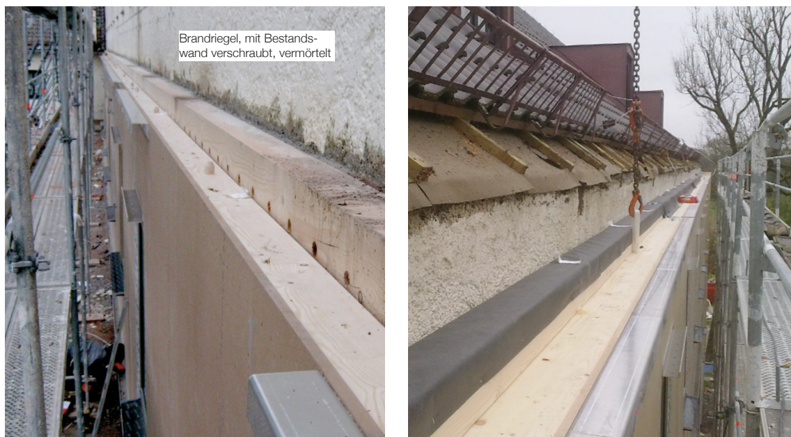
Abb. 46 Horizontaler Elementstoß und Dachabschluss (Foto links: BAUFRTITZ)
