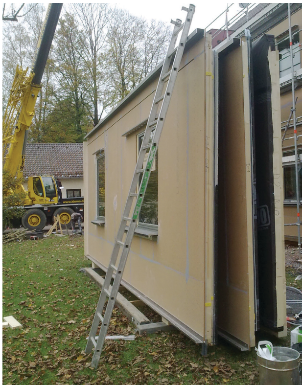
Abb. 45 Montage mit Autokran (Foto rechts: BAUFRITZ)
