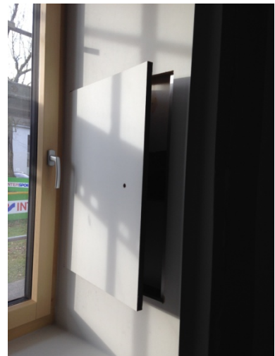
Bild 6: Klappenöffnung in der Laibung
