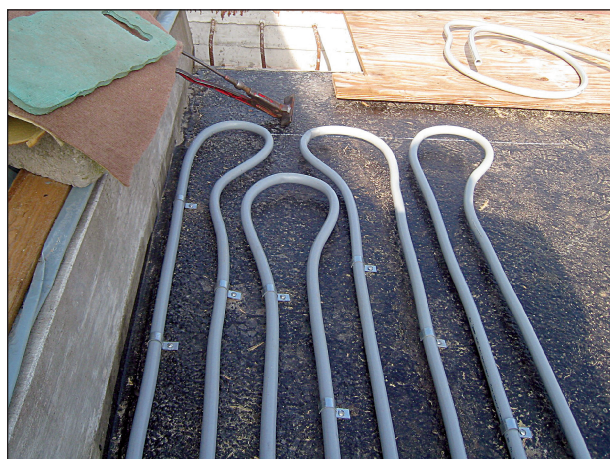
Bild 4: Rohrbiegung
