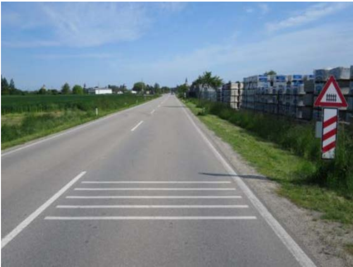
Abbildung 52: Markierungsblock an erster Bake vor BÜ [52]
