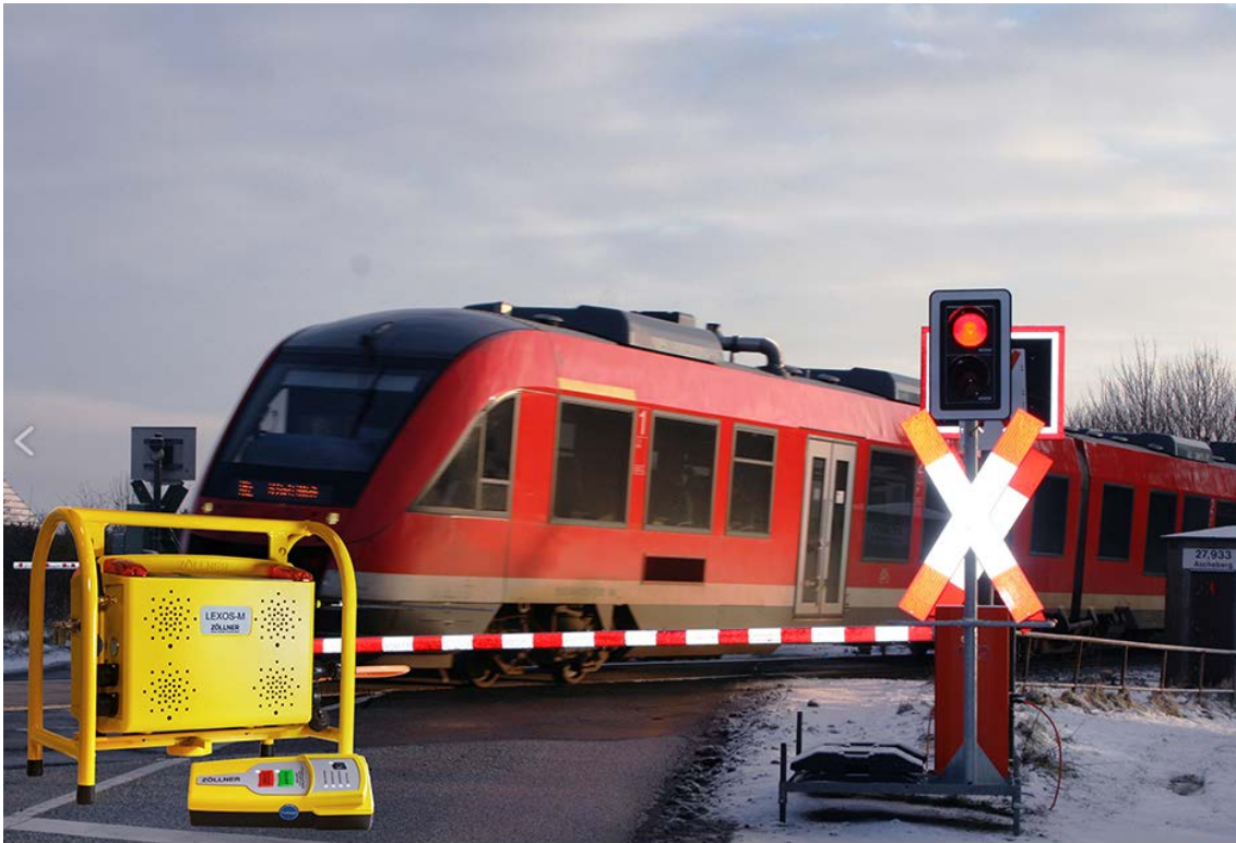
Abbildung 54: Mobile Sicherungsanlage mit Nachwarnung [55]
