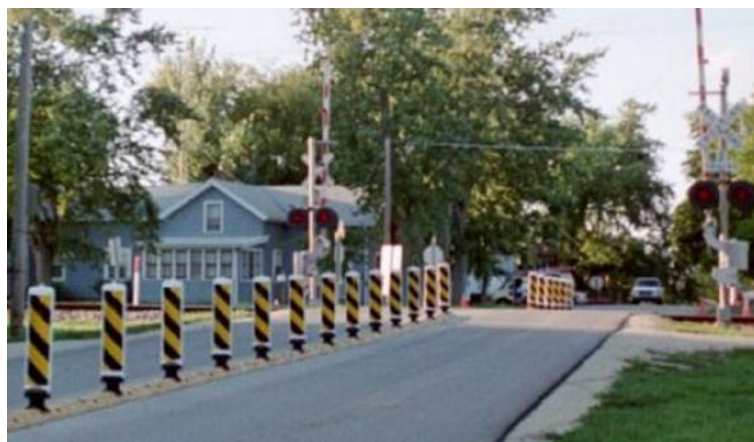
Abbildung 41: Fahrbahnteiler am BÜ [22]
