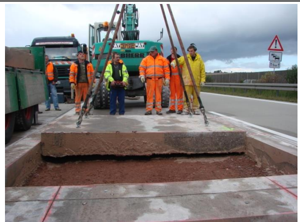
b. Aufnahme großformatiger Plattenausschnitte
