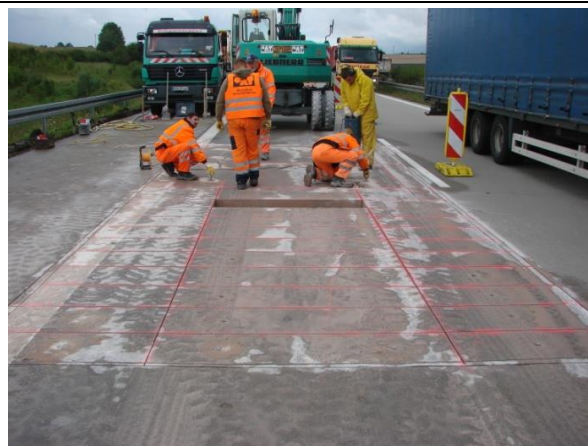
a. Einbringen der Lastaufnahmeösen in Betonfahrbahndecke
