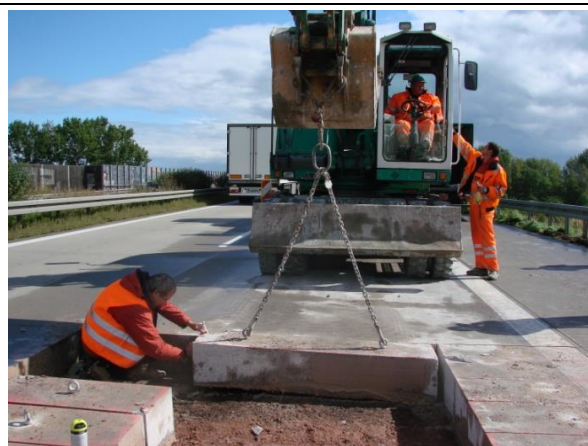
c. Bezeichnung und Aufnahme kleinformatiger Fahrbahnsegmente
