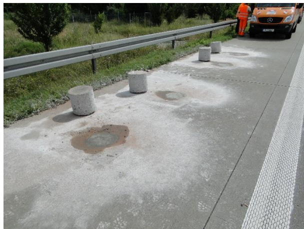
Bohrkerntnahme
