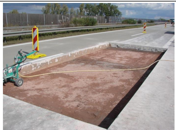
d. Übersichtsbild nach erfolgter Plattenentnahme
