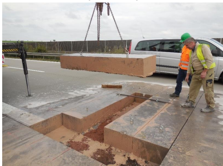
Entnahme der Balkensegmente
