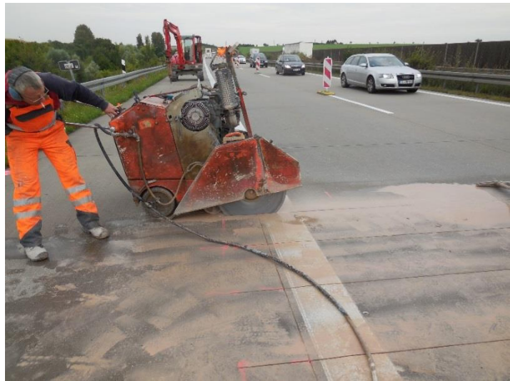
Zuschnitt der Balkensegmente
