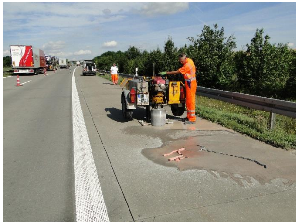
Bohrkerntnahme
