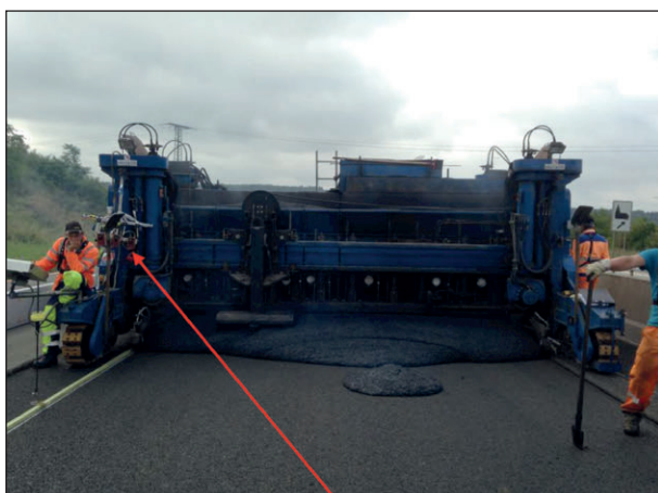
Bild 98: Messung der Dämpfe und Aerosole beim Einbau von Gussasphalt ohne viskositätsverändernde Zusätze auf der BAB A 61 (Pfeil zeigt auf stationäre Messstation) [BG BAU, Teil 4]
