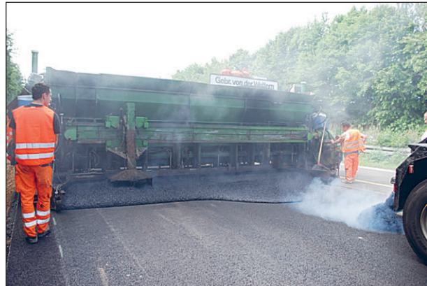
Bild 27: Maschineller Gussasphalteinbau
