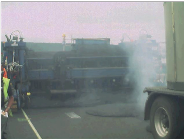
Bild 96: Zapfen von Gussasphalt ohne viskositätsverändernde Zusätze für den Handeinbau auf dem Gelände der Zeche Zollverein in Essen, [BG BAU, Teil 2]
