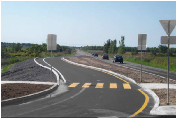
Bild 174: Verlängerter aufgeweiteter Fahrbahnteiler mit drei aufeinanderfolgenden Kurven in der Zufahrt (Bildquelle: RICHTIE, 2005)
