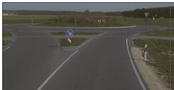
Bild 170: Fahrbahnteiler mit dem Fahrbahnverlauf angepassten Rändern und Querungsstelle in Dreiecksform (Bildquelle: ZEB, 2018)
