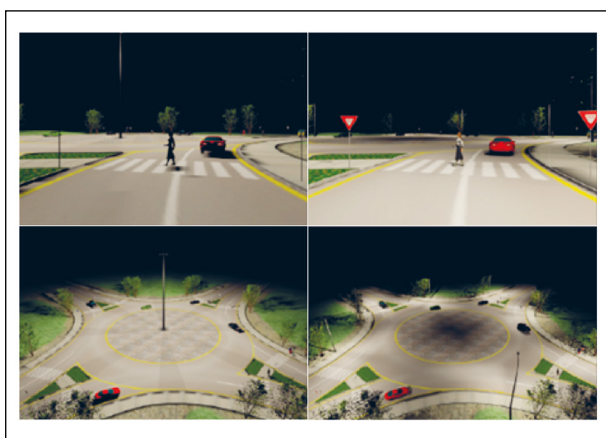
Bild 56: Beleuchtung der Kreisinsel (links) und Beleuchtung des Kreisverkehrsrandes (rechts) | Vereinigte Staaten (IES, 2008)
