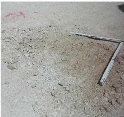
Bild 71: Aufgrabung Boden für die Herstellung einer Sandausgleichsschicht im Feld 1 (Foto: Christoph Henzinger)
