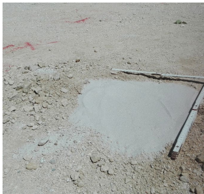
Bild 72: Herstellung einer Sandausgleichsschicht im Feld 1 (Foto: Christoph Henzinger)
