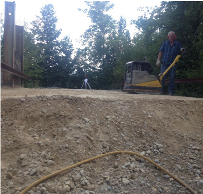
Bild 61: Verdichtung der zweiten Lage im Feld 1 (Foto: Elisavet Barka)
