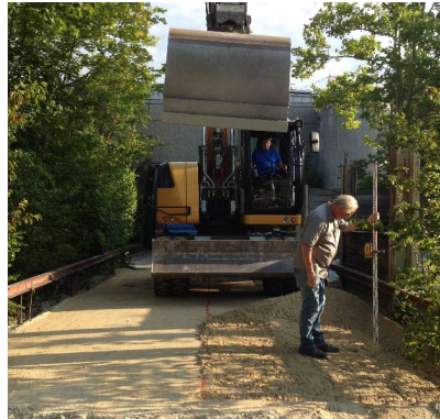
Bild 62: Herstellung der geeigneten Bankettoberflächen im Feld (Foto: Elisavet Barka)
