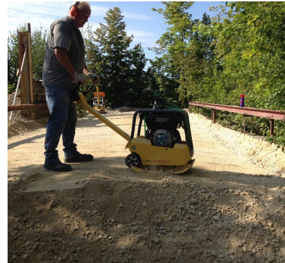
Bild 63: Verdichtung der geeigneten Bankettoberfläche im Feld 1 (Foto: Elisavet Barka)
