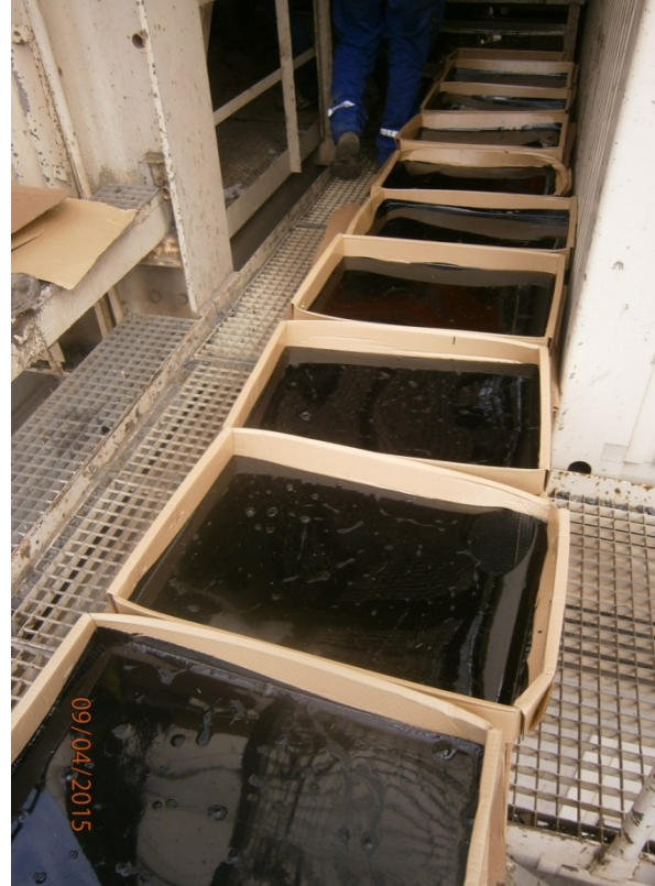
Bild 7.1 Bereitstellung der Bitumenplatten für die Zugabe in den Mischer
