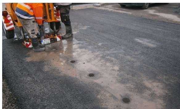
Bild 7.5 Bohrkernentnahme (hier D = 150 mm)
