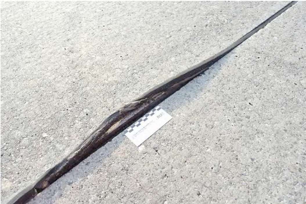
Bild 215: Flankenablösung (A24)
