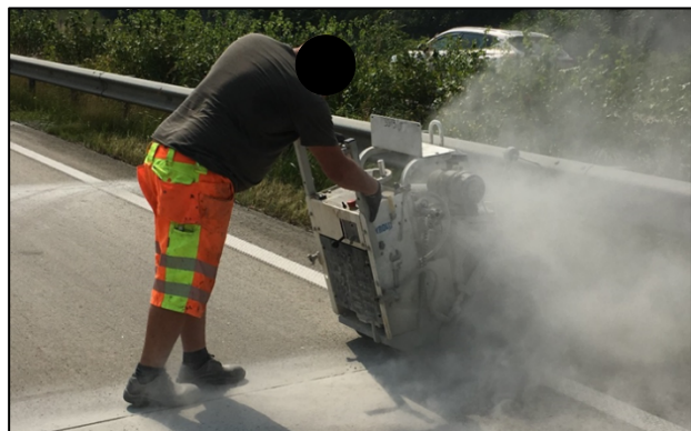
Bild 226: Anfasen der Querscheinfugen
