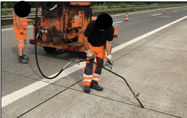
Bild 232: Einbau heiß verarbeitbare Fugenmasse (FM6)
