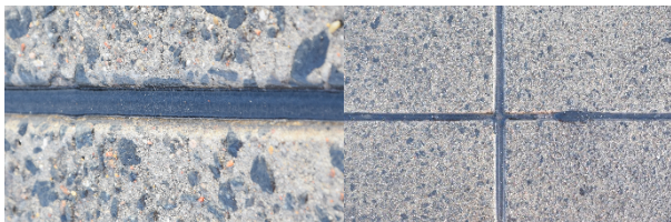
Bild 165: Beispielhafte visuelle Zustandserfassung in Testfeld 2.1 und 2.2 im Januar 2018
