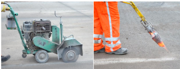
Bild 4: links: Reinigen mit rotierender Drahtbürste; rechts: Trocknen mit Heißluftlanze
