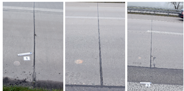
Bild 128: Detail der Zustandserfassung A40 – undichtes Fugenfüllsystem
