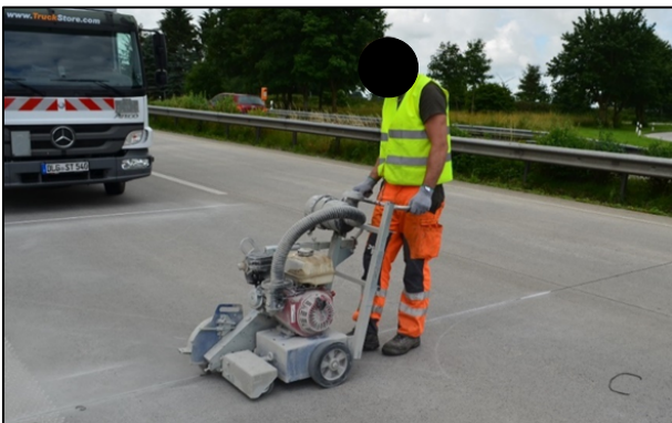
Bild 227: Reinigung mit rotierender Drahtbürste
