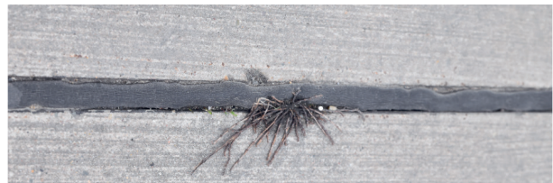
Bild 128: Detail der Zustandserfassung A40 – undichtes Fugenfüllsystem
