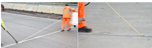
Bild 5: links: Einbringen der Unterfüllschnur; rechts: Applizieren des Voranstrichs
