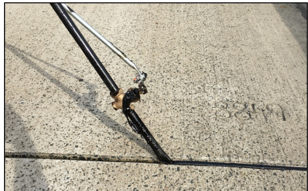
Bild 233: Einbau heiß verarbeitbare Fugenmasse (FM6) - Detail
