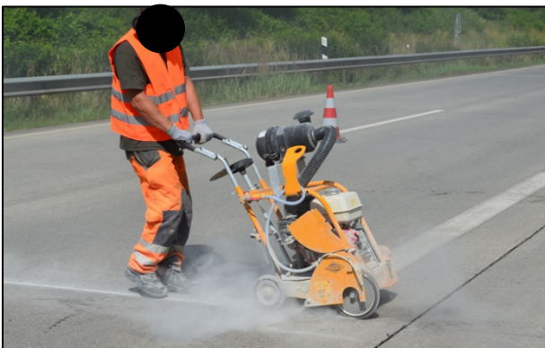
Bild 225: Nachschneiden der Querscheinfugen
