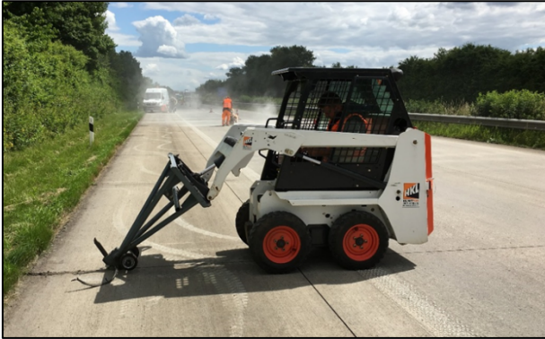
Bild 223: Entfernen der Fugenprofile
