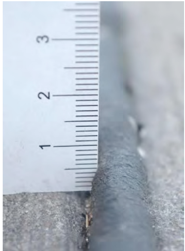
Bild 220: links: abgesackte Fugenmasse (A30); rechts: überdrückte Fugenmasse im Standstreifen (A30)
