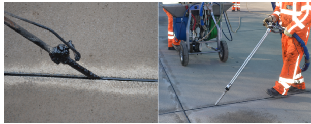
Bild 6: Einbringen von Fugenmasse (links: Heißverguss; rechts: Kaltverguss)
