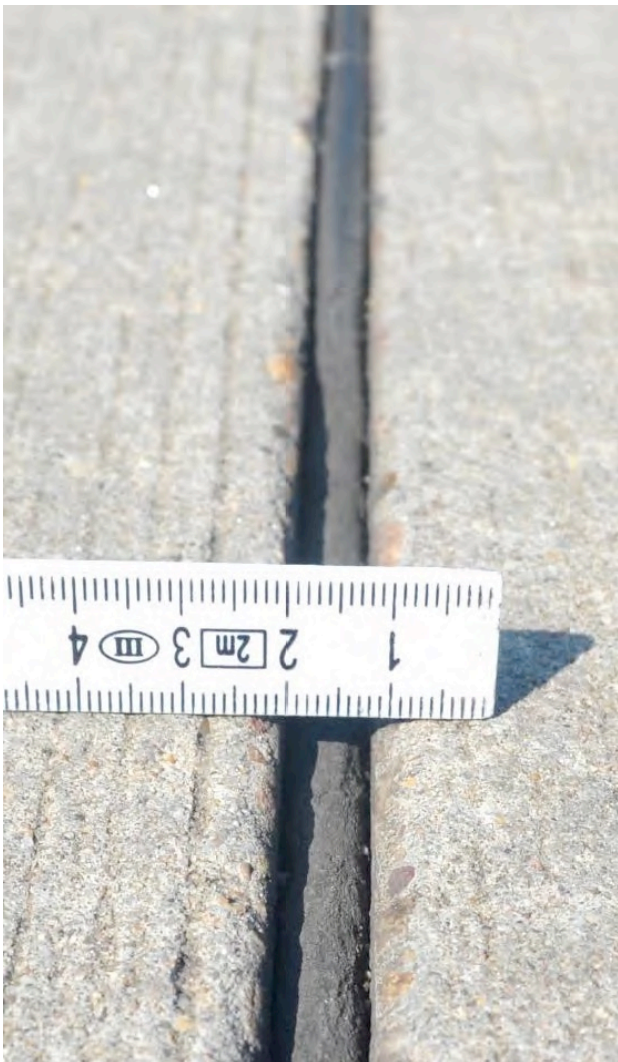
Bild 220: links: abgesackte Fugenmasse (A30); rechts: überdrückte Fugenmasse im Standstreifen (A30)
