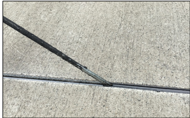
Bild 231: Einbau kalt verarbeitbare Fugenmasse (FM7) - Detail
