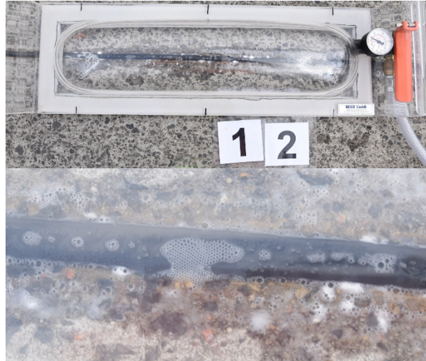
Bild 174: Dichtheitsprüfung mittels Vakuumsaugglocke am Beispiel: wenige Blasen, lokal <5 cm (oben Gesamtaufnahme, unten: Detail)
