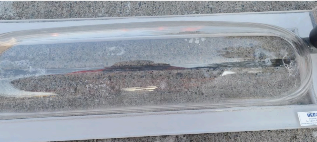
Bild 218: Dichte Fuge (A27)
