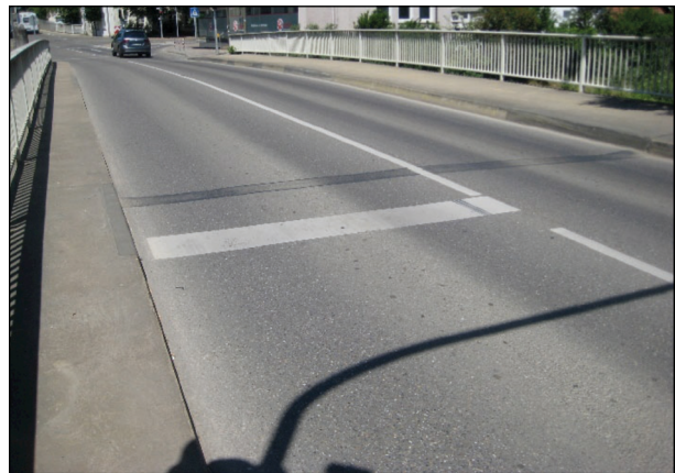
Bild 94: Belagsdehnfuge, Schillerbrücke über die Fils (10)
