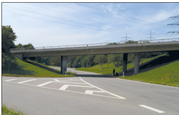
Bild 75: Brücke im Zuge der B 500 über die K 6563 bei Gaiss (1)
