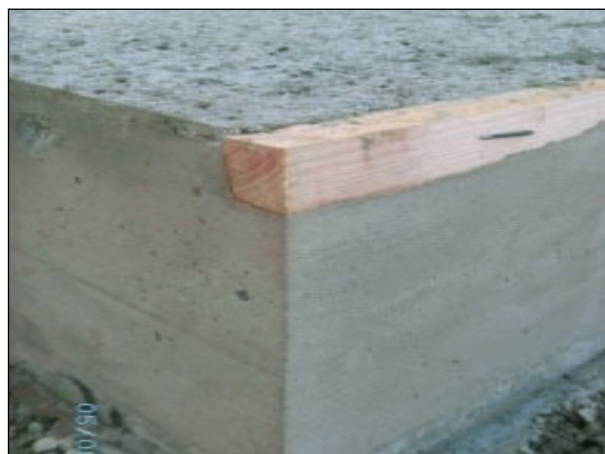
Bild 98: Ausparung in der Betonplatte für die spätere Belagsdehnfuge (12)
