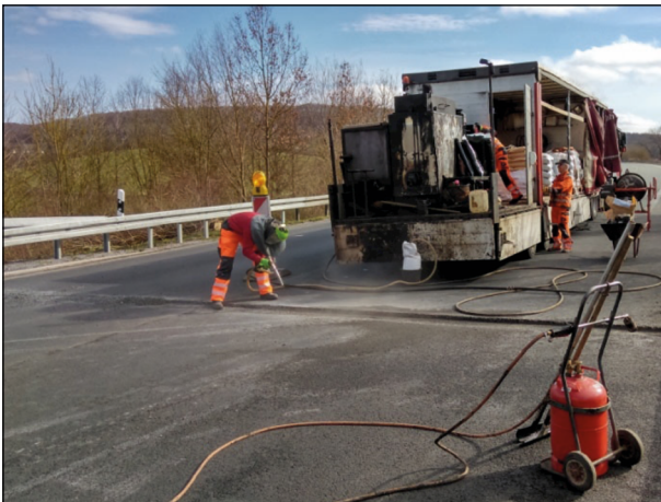
Bild 15: Sandstrahlen der Fugenmulde (1)
