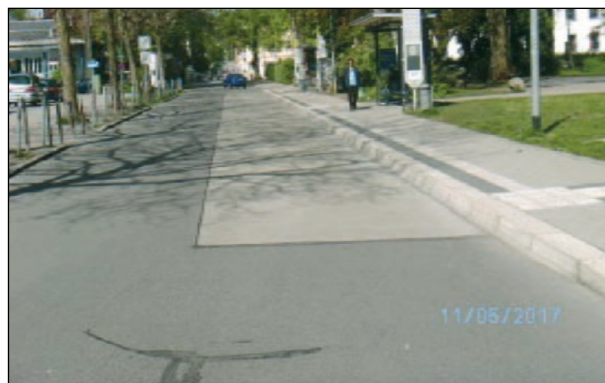
Bild 97: Betonsegment mit Belagsdehnfugen in der Busspur (12)
