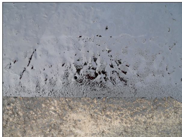
Bild 28: Komplett mit Tränkmasse gefülltes Gesteinskörnungsgüst der Muldenfüllung (1)
