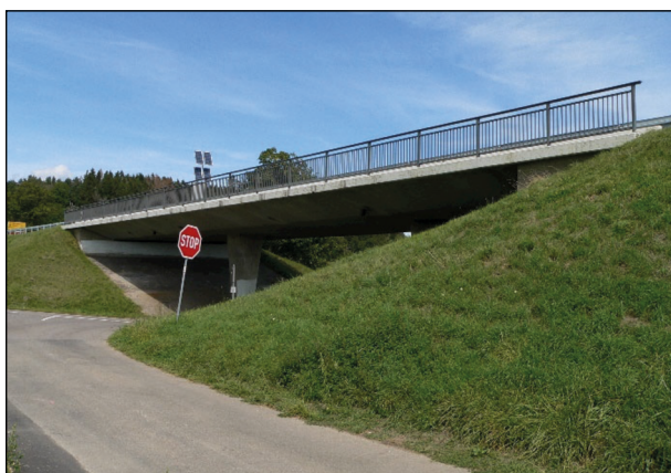
Bild 77: Brücke im Zuge der B 500 über die K 6563 bei Gaiss (1)
