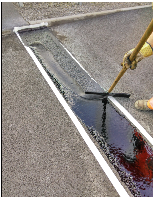
Bild 26: Verteilen der Tränkmasse (1)
