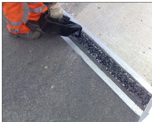
Bild 113: Verfüllen mit Tränkmasse (15)
