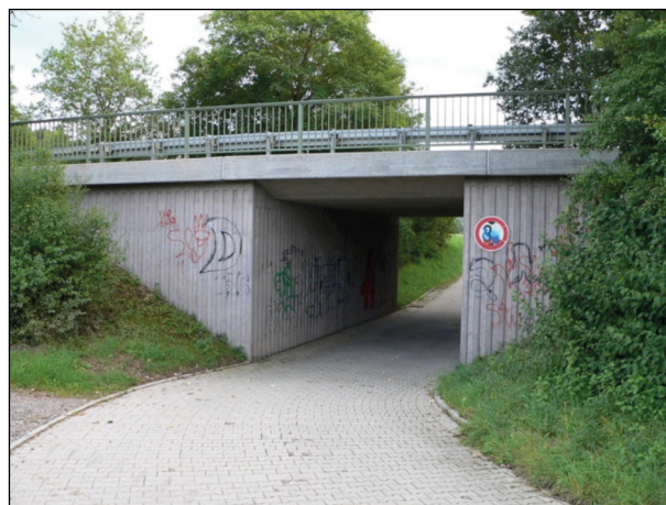
Bild 70: Überführung des Außenringes in Villingen-Schwenningen über einen Fuß- und Radweg (1)
