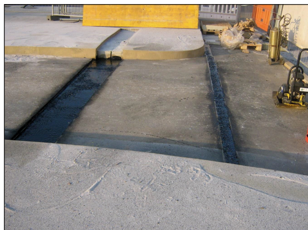
Bild 36: Einbau der Belagsdehnfuge und der Fahrbahnübergänge aus Asphalt (3)
