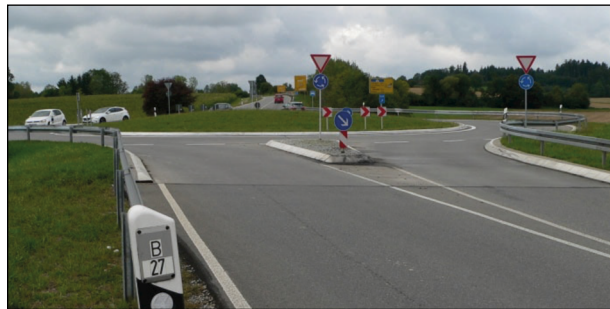
Bild 56: Kreisverkehr im Zuge der B 27 in Rottweil (1)
