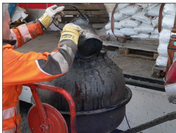
Bild 20: Zuführung von Tränkmassse zu der Gesteinskörnung zur Umhüllung (1)
