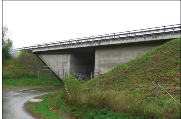
Bild 48: Wirtschaftswegunterführung im Zuge der BAB A 81 (1)
