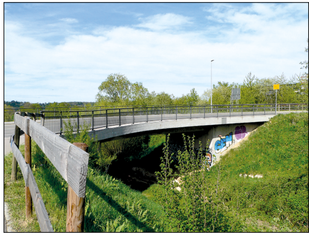
Bild 41: Brücke über die Lauter im Zuge der L 1200a (1)
