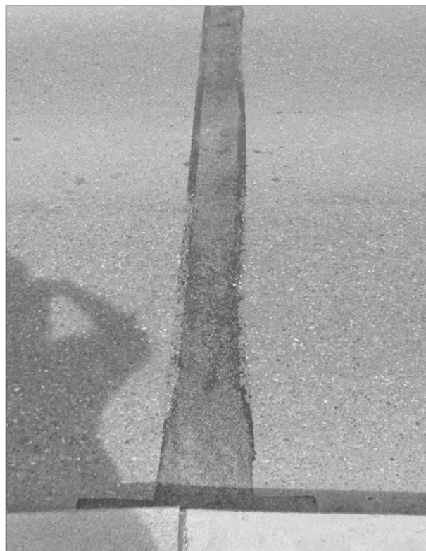
Bild 45: Belagsdehnfuge nach 7 Jahren unter Verkehr (2019) ohne Schäden (1)
