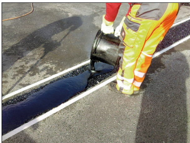
Bild 25: Einbringen der heißen Tränkmasse (1)
