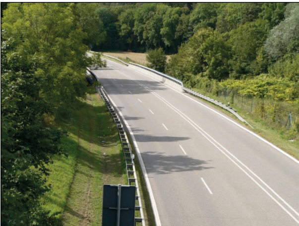
Bild 81: Brücke über die Steina im Zuge der BAB A 98 (1)
