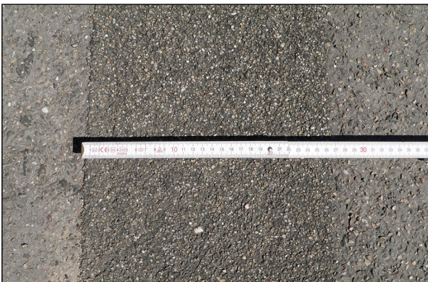
Bild 47: Belagsdehnfuge in 26 cm Breite nach 7 Jahren unter Verkehr ohne Schäden (1)
