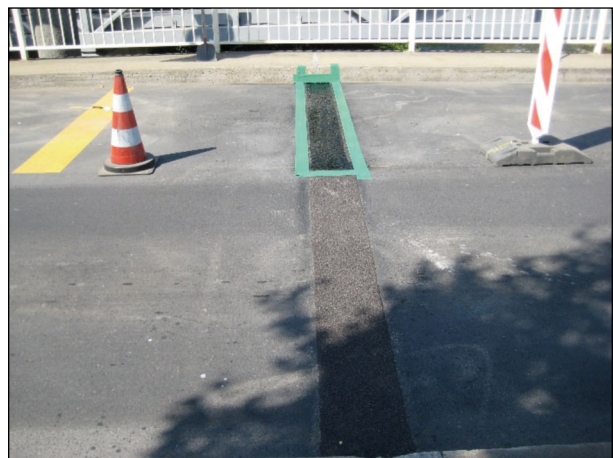
Bild 95: Fahrstreifenweiser Einbau der Belagsdehnfugen (10)
