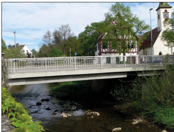
Bild 43: Aichbrücke in Nürtingen-Oberensingen (1)
