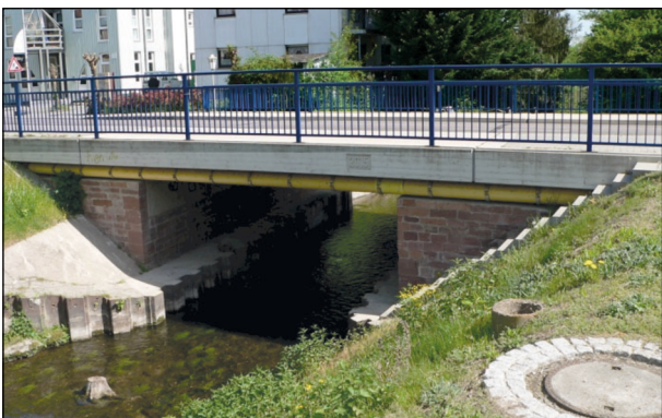
Bild 54: Federbachbrücke in Neuburgweiher (1)
