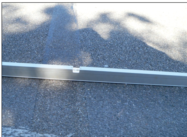
Bild 33: 20 cm breite Belagsdehnfuge nach 10 Jahren unter Verkehr - keine Verformungen in Fahrtrichtung (1)
