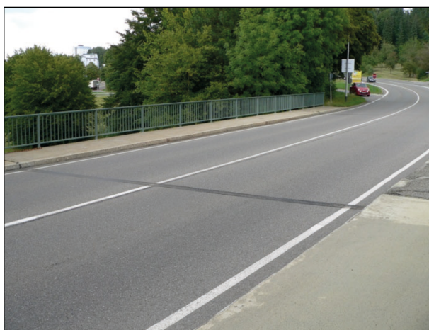
Bild 68: Überführung der Schwenningerstraße über den Fürstenbergring (1)
