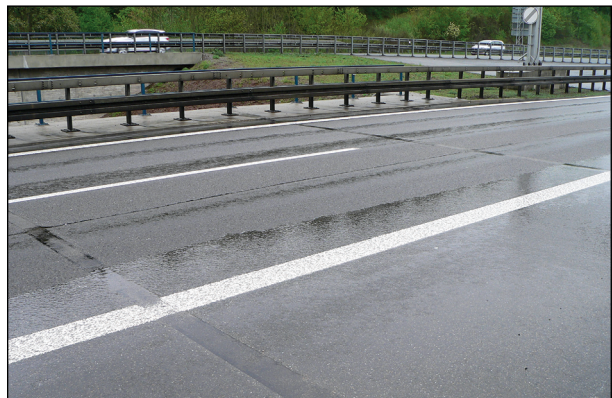
Bild 49: Belagsdehnfugen im Zuge der BAB A 81 bei Herrenberg nach 5 Jahren unter Verkehr ohne Schäden (1)
