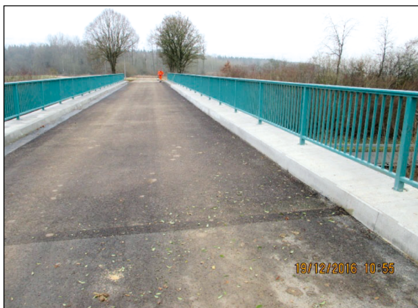
Bild 104: Feldwegüberführung über die L 456 bei Sigmaringen (13)
