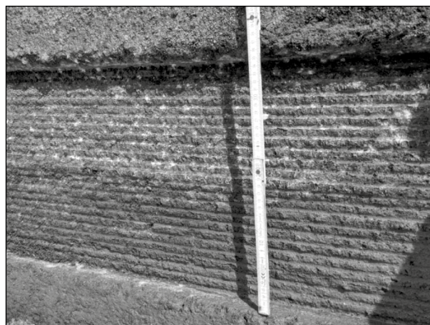
Bild 13: Ausgefräste Fugenmulde (1)
