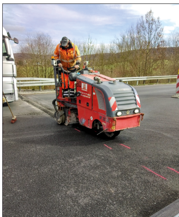
Bild 12: Ausfräsen der Fugenmulde entlang der Anzeichnung
