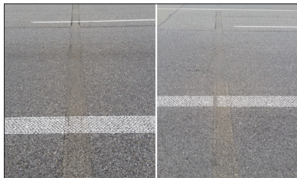
Bild 111: Belagsdehnfugen im Zuge der B 500 über einen Baggersee bei der Schleuse Iffezheim nach 6 Jahren unter Verkehr ohne Schäden (14)
