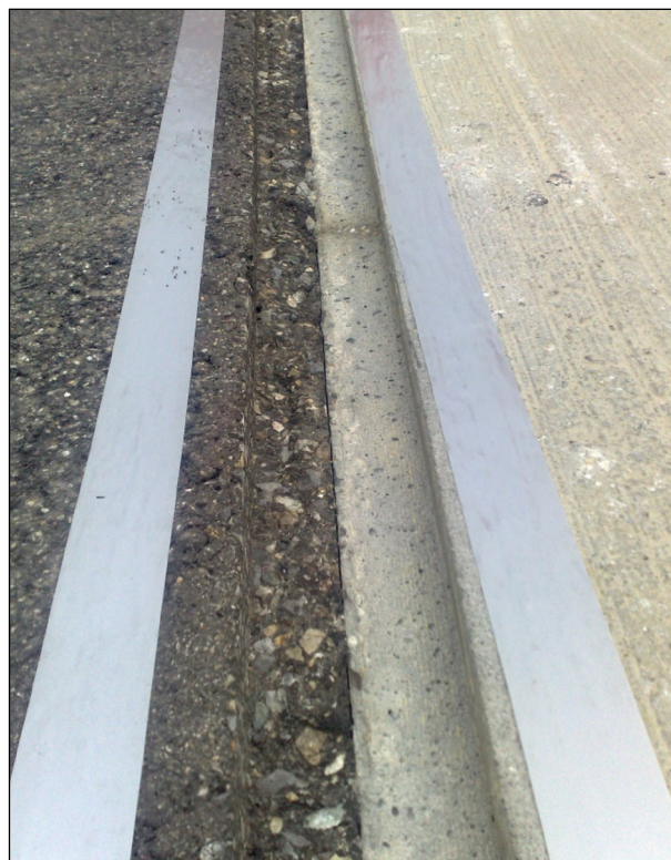
Bild 112: Vorbereitete Mulde zwischen Asphalt- und Betonfahrbahn (15)
