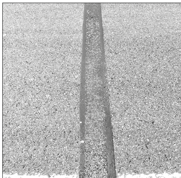
Bild 53: 14 cm breite Belagsdehnfuge im Zuge der L 562 nach 3 Jahren unter Verkehr ohne Schäden (1)
