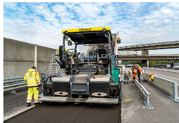
Ablauf Einbau Kaltrecyclingschicht auf dem duraBAST
