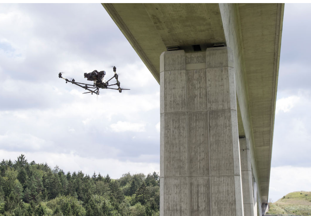
UAS an einem Brückenbauwerk (Bild: gmtib)
