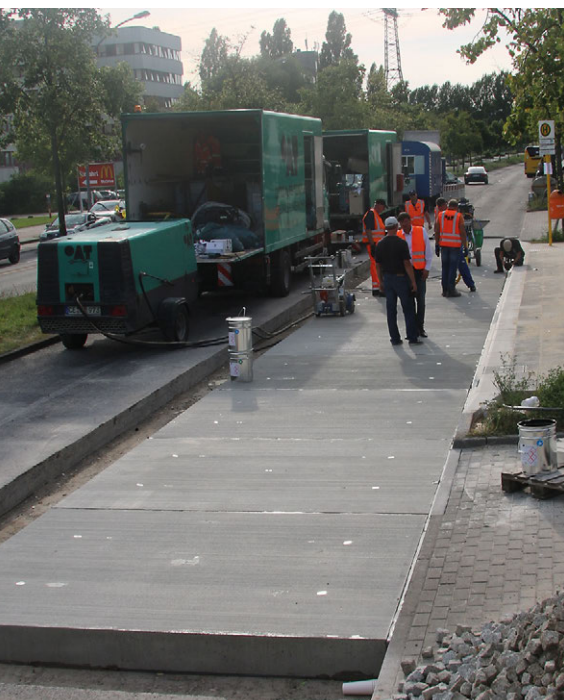
Demonstrator im Bereich einer Bushaltestelle
