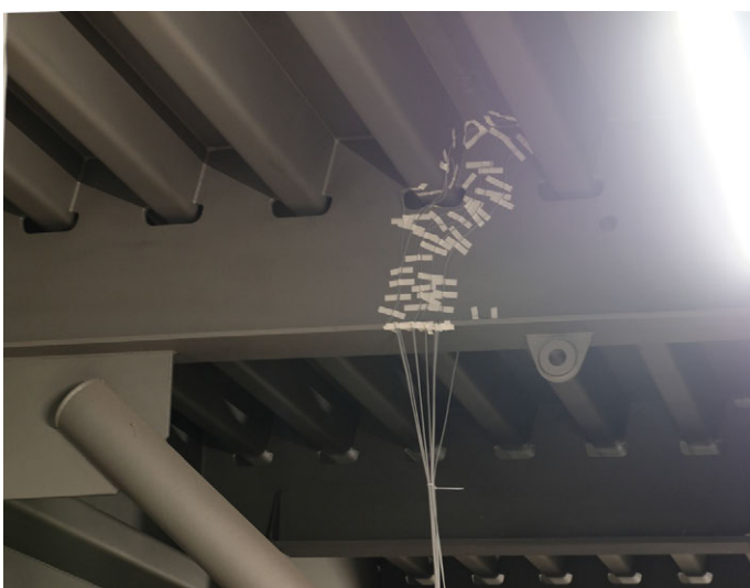
Positionierung der Temperatursensoren im Brückeninneren bei Querträger Nr. 6
