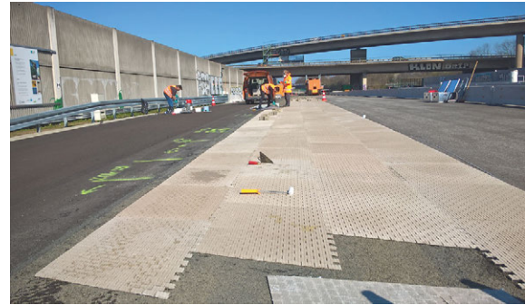
Herstellung des Inno-Pave-Belags
