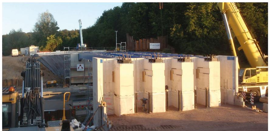
Überführungsbauwerk in Modulbauweise
