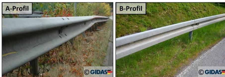
Abbildung 2-3: Profilartern bei Stahlschutzplanken (li.: A-Profil | re.: B-Profil)
