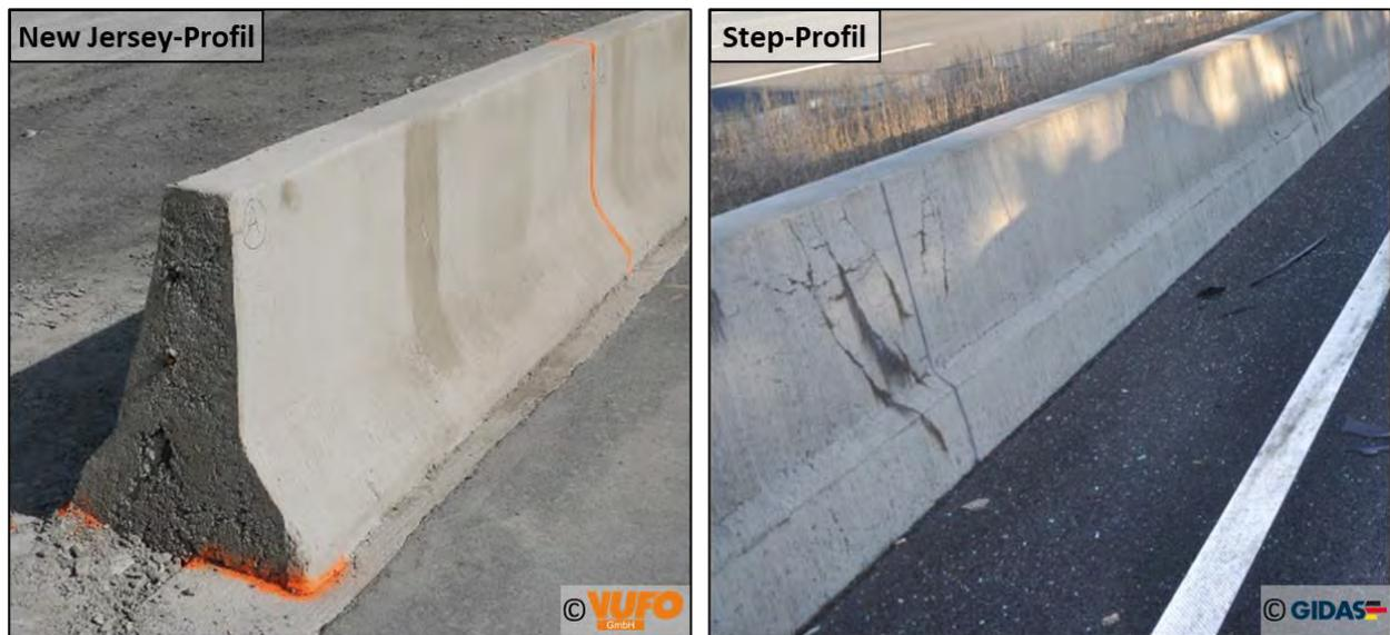
Abbildung 2-4: Profile von Betonschutzwänden (li.: New Jersey-Profil | re.: Step-Profil)
