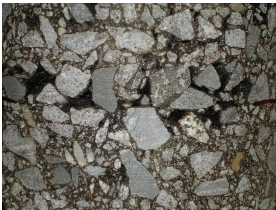
Abbildung 1: Ausrichtung der Gesteinskörner und Hohlräume an der Schichtengrenzfläche (ABi 0/16 S / ATS 0/22 CS)
