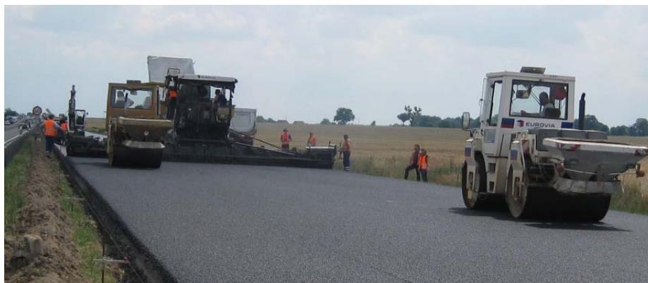
Abbildung 45: Einbau von offenporigem Asphalt auf der Autobahn A24 im Rahmen des Forschungsprojektes „Leiser Verkehr II“ ([BRANDENBURG 2009])
