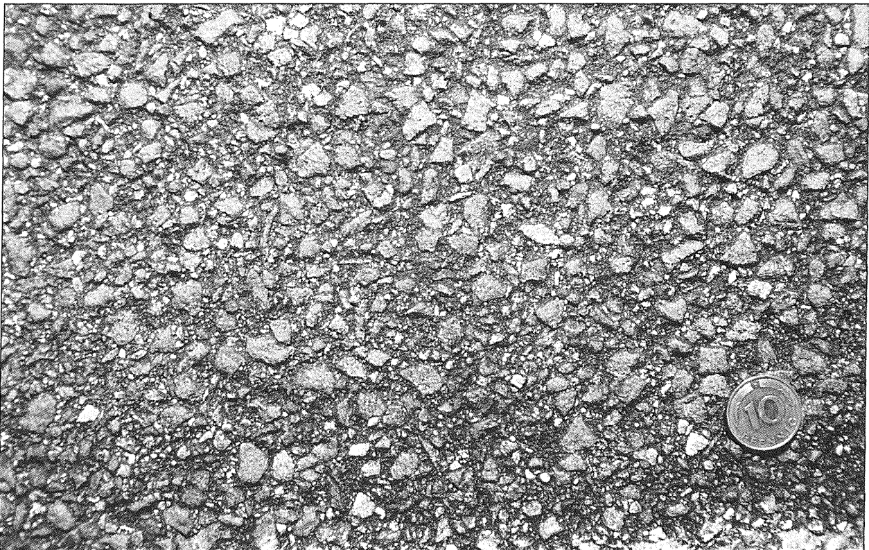
Bild 6.1: Oberfläche der im Prüfstandsversuch zum Rollwiderstand verwendeten Asphaltbetondecke 0/11s
