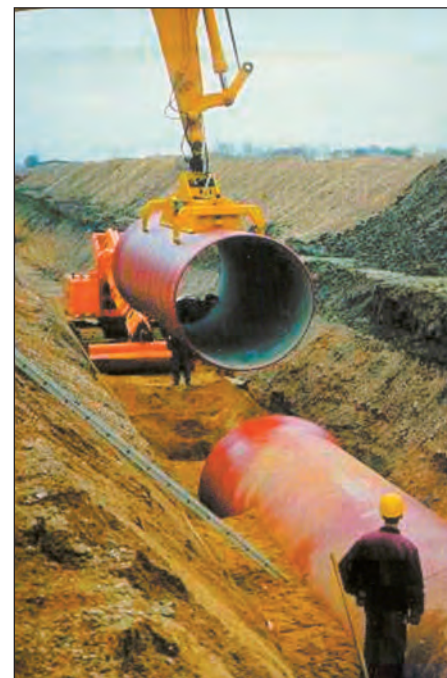
Bild 19: Verlegen eines 8 m langen Druckrohr-Abschnittes aus duktilem GJS in einem Braunkohletagebau (Bild: ZGV)
