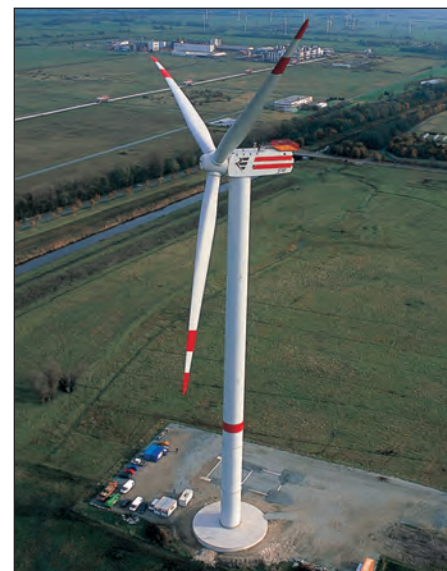
Bild 140: Prototyp der 5MW-Windenergieanlage REpower 5M in Brunsbüttel (Bild: REpower, Hamburg)
