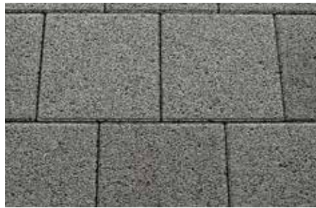
Bild 30: Sickerpflaster mit haufwerksporigem Betongefüge https://delfing.de/produkte/oekologische-pflaster/
