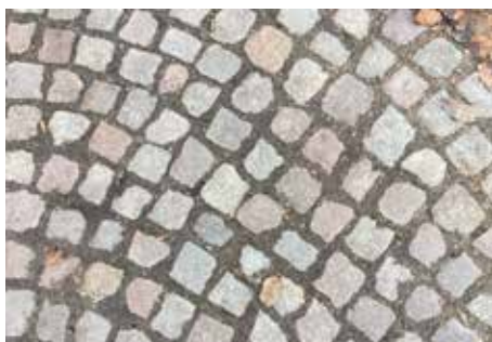
Bild 42: Gebrauchtes Granit-Kleinpflaster. Polygonalverband (Passe)
