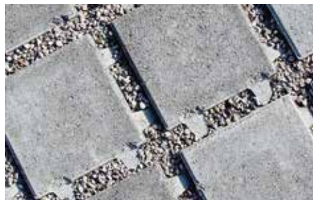
Bild 31: Sickerpflaster – Stein mit Abstandshaltern und Splitt-Fugenfüllung https://www.steinwerke.at/gartentraeume/produkte/oeko-line/verde.html
