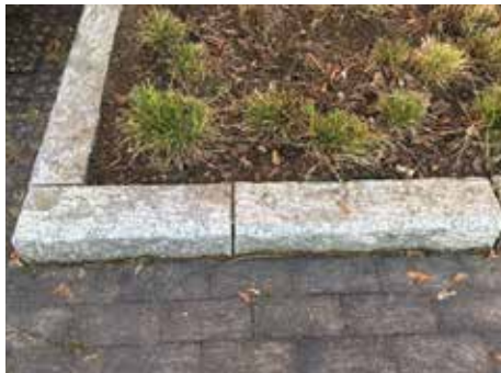
Bild 49: Granit-Bordstein als Randbefestigung
