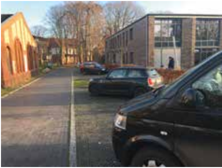
Bild 35: Stellplätze in Schrägaufstellung mit Rasenloch-Klinkern befestigt.
