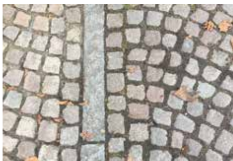
Bild 43: Gebrauchtes Granit-Kleinpflaster. Polygonalverband (Passe) mit Abgrenzung
