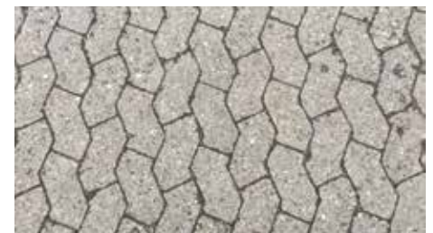
Bild 29: Beton-Verbundsteine SF-Pflaster)
