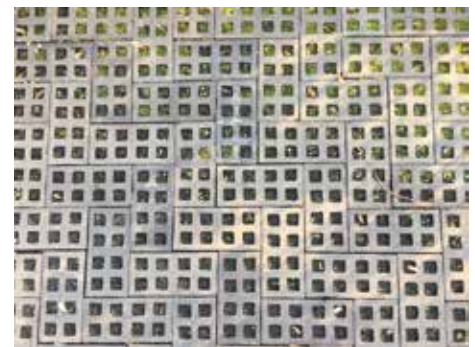
Bild 33: Rasenloch-Klinker Fischgrät-Verband
