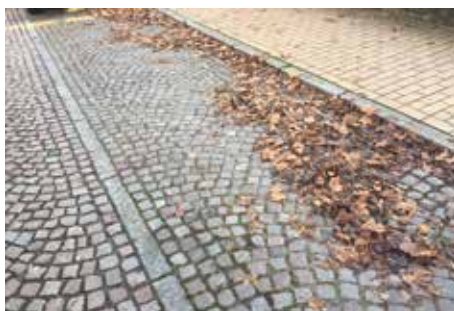
Bild 45: Granit-Kleinpflaster – Reihenverband
