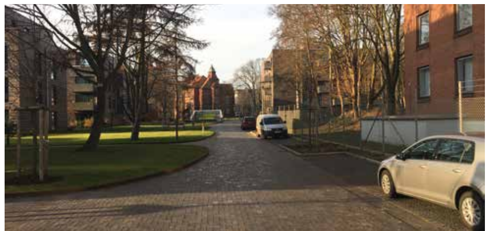
Bild 37: Pflasterklinker im Fischgrät-Verband. Stellplätze in Längsrichtung mit Rasenloch-Klinkern befestigt
