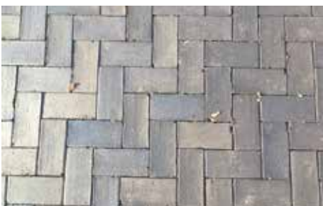
Bild 36: Pflasterklinker im Fischgrät-Verband
