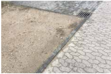
Bild 48: Stellplatzanlage: Befestigung mit Beton-Verbundpflaster, Beton-Rechteckpflaster und einer wassergebundenen Decke
