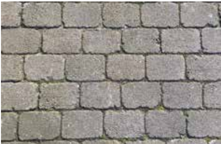
Bild 27: Betonpflaster mit „gerumpelten“ Kanten
