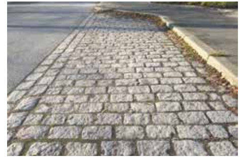
Bild 38: Neues Granit-Großpflaster, grau, im Reihenverband versetzt. Stellplätze in Längsrichtung
