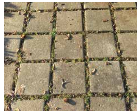
Bild 32: Sickerpflaster – Stein mit Abstandshaltern und Rasenfugen
