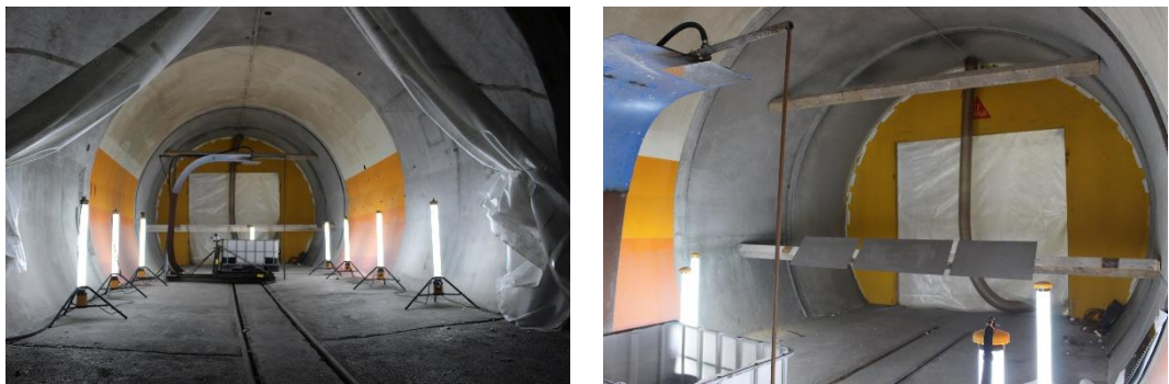
Abbildung 8 Versuchsplatz Stollen «A» (links) mit Abluftreinigungsvorrichtung (rechts)
