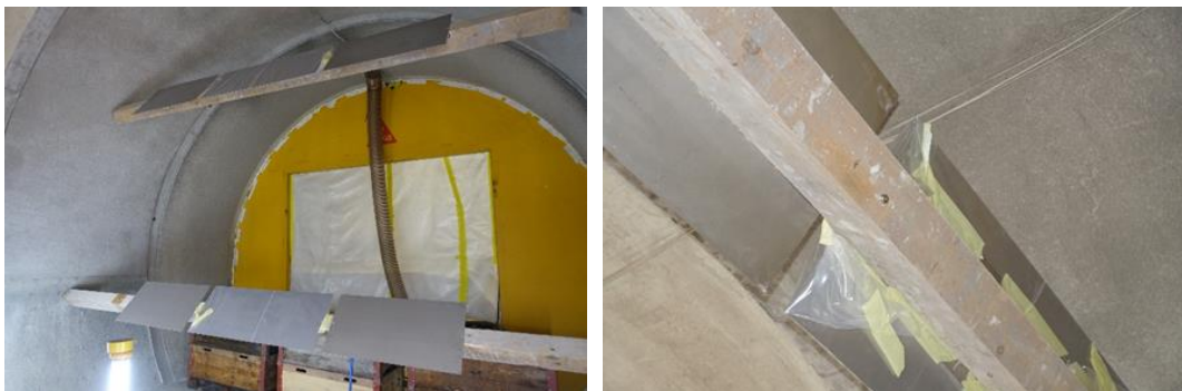
Abbildung 33 Klima-Monitoring Stollen A (links) und B (rechts)
