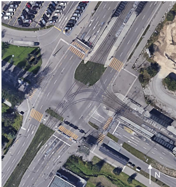
Abb.173 Städtischer Grossknoten mit Lichtsignalanlagen und starkem ÖV-Einfluss (Trams), Knoten Thurgauer-/Glattparkstrasse in Zürich/Opfikon (swisstopo, 2020)
