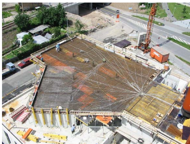
Abb. 5: Bau einer Geschossdecke mit Betonkernaktivierung
